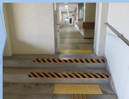
段差が目立つように、テープや点字ブロックのシートを貼る
